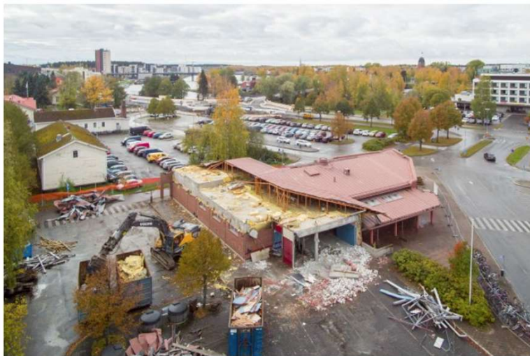
Kuva Matkahuollon rakennuksen purkutöistä tiistailta.
