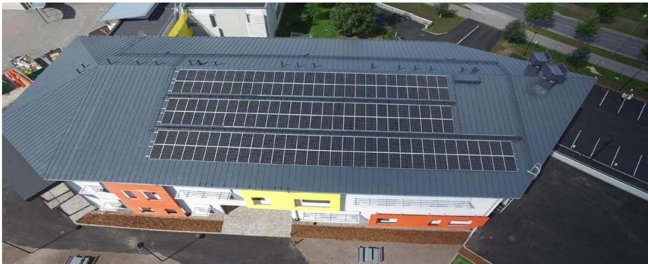
Kuva 6. Lappeenrannan Myllymäen päiväkodin aurinkopaneelit.
