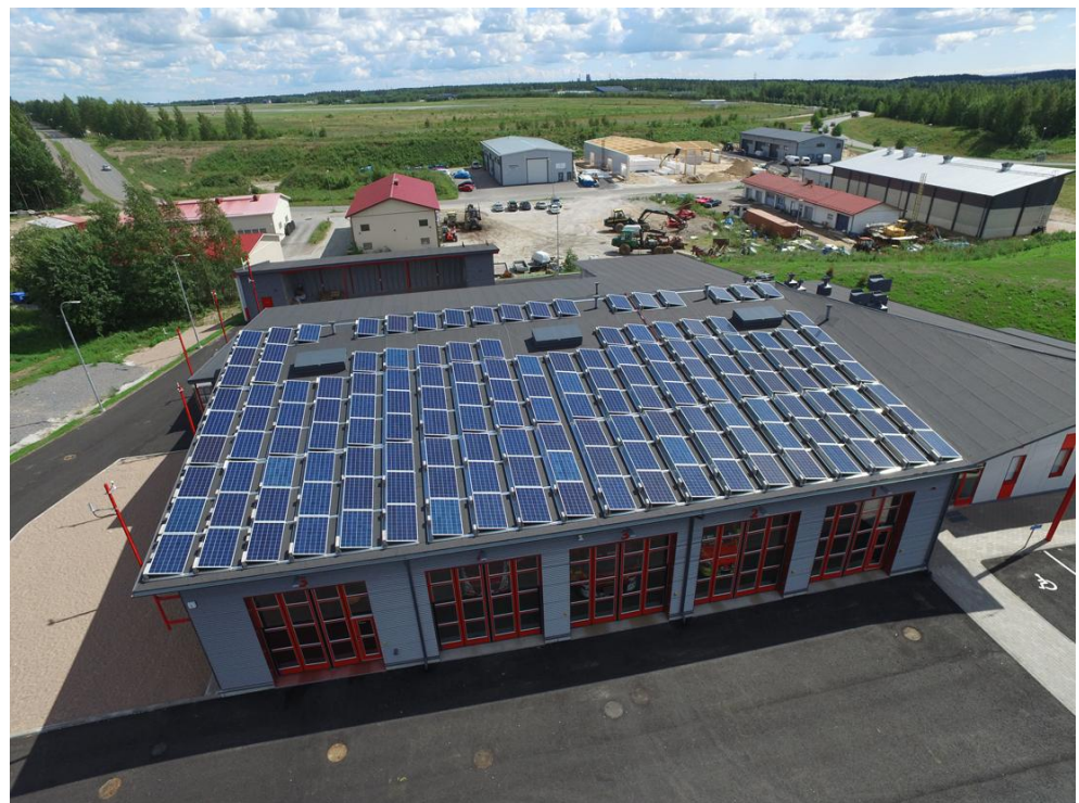
Kuva 1. Lappeenrannan läntisen paloaseman aurinkopaneelit.
