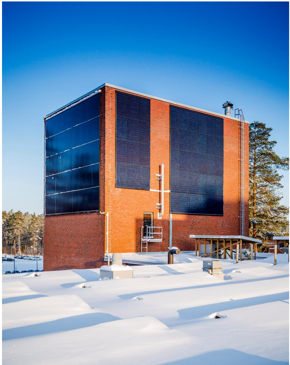
Kuva 11. Aurinkopaneeleita rakennuksen julkisivussa Lappeenrannan teknillisellä yliopistolla. (Kuva: LUT)
